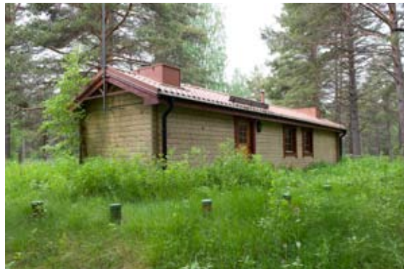
Pumpstation för grundvattenbrunnar.
