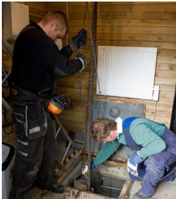
Byte av avloppspump.
