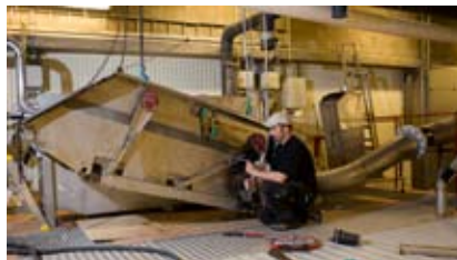
Reparationsarbete i reningsverket.
