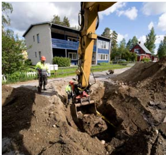
Reparation av vattenläcka.
