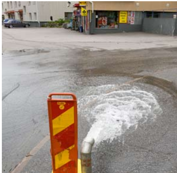
Renspolning av vattenledningsnätet.
