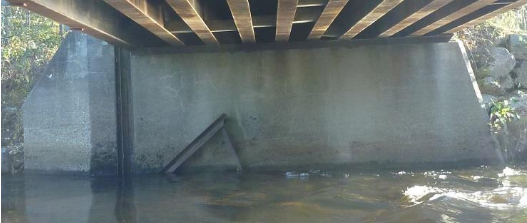
Figur 7 Landfäste, synes vara i gott skick. Sättare utanför yttrebalk till vänster i bild.
