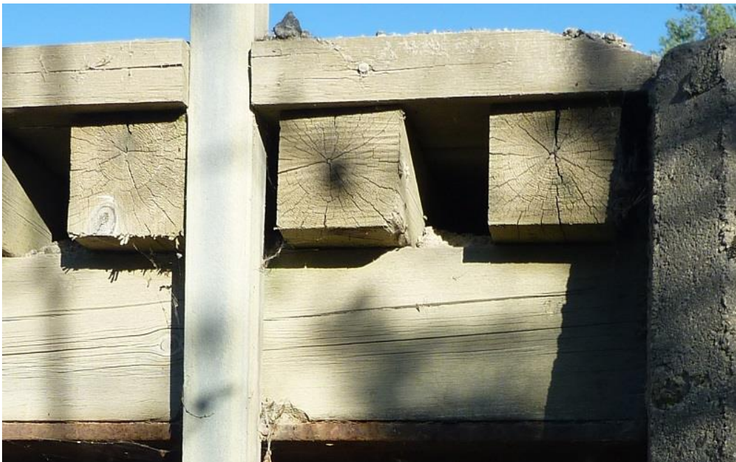
Figur 3 Medfaren träkonstruktion med sprickor och viss röta som vittne.
