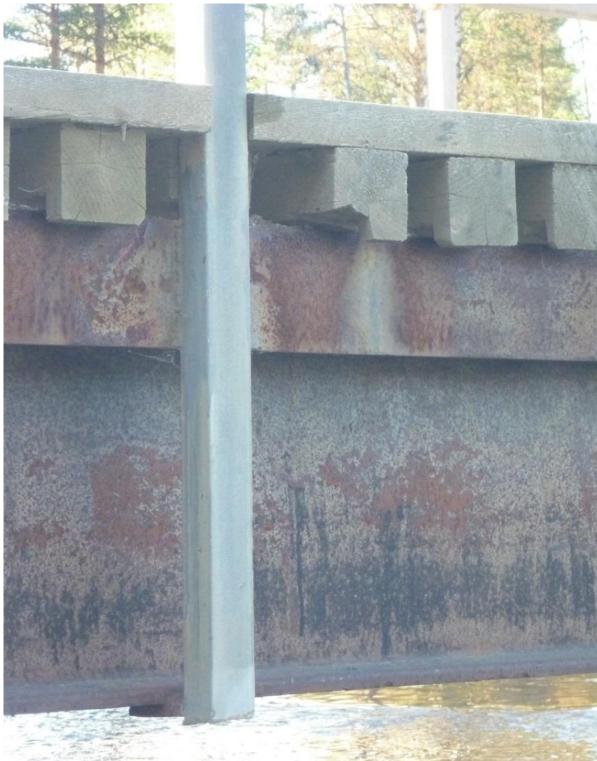
Figur 4 Räck inte infäst enligt standardlösning, östra sidan.
