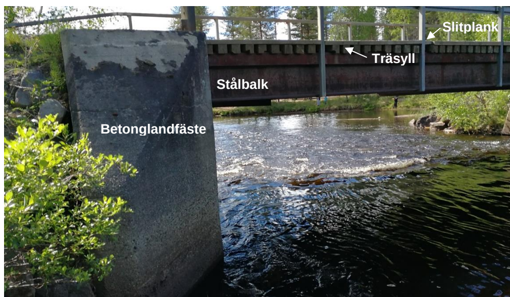
Figur 5. Foto av del av bro över Lycksbäcken.
