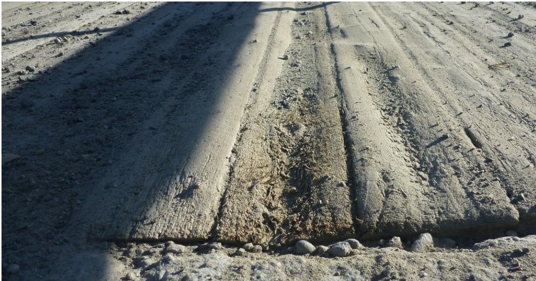
Figur 2 Brobana, slitplank var slitna och utsatta för röta.
