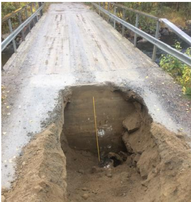
Figur 6. Vy över nedströms schaktvägg där man ser uppbyggnaden av brostödet.
