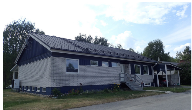
Villa från 1970-talet med fasad av kalksandsten (Mexi) och stående och liggande träpanel i blå lasyr.
