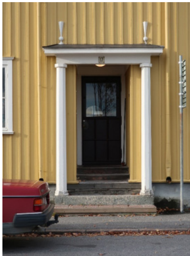
Entrén till Granen 1 markeras med pelare som bär upp ett nätt skärmtak.
