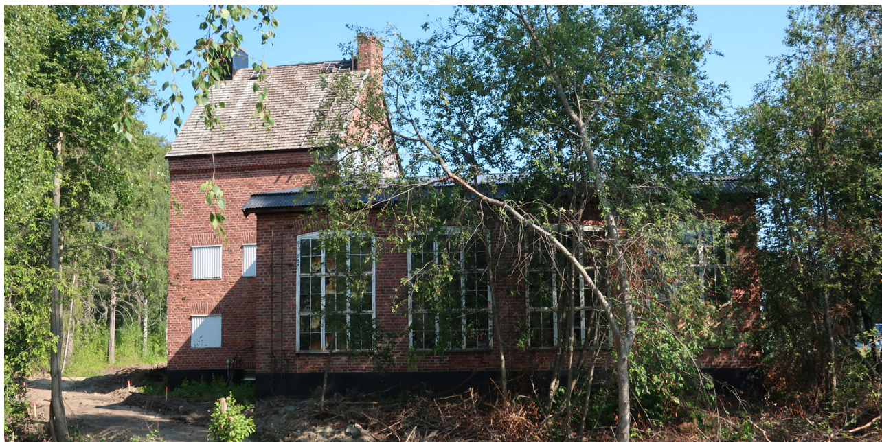
Lokstall, foto från söder.
