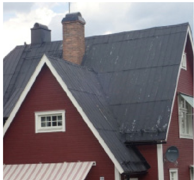
Spetsigt sadeltak, liggande panel och småspröjsade fönster. Bostadshus på Smedsberget, Villaryd
