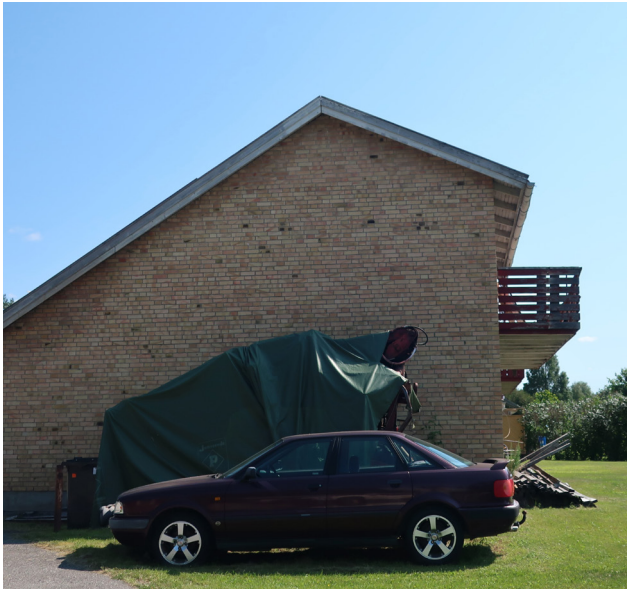
Gavelfasad, kedjehus vid Lunnvägen.
