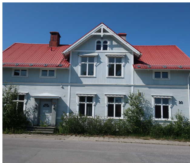
Kontorshus på Dickson 18, ny entrédörr och färgsättning. Ursprungliga fönster.
