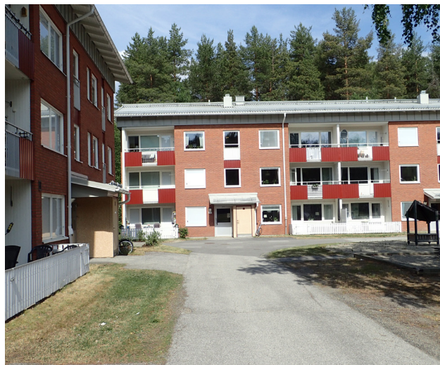
Flerbostadshusens fasader mot innergården, Näsan 1
