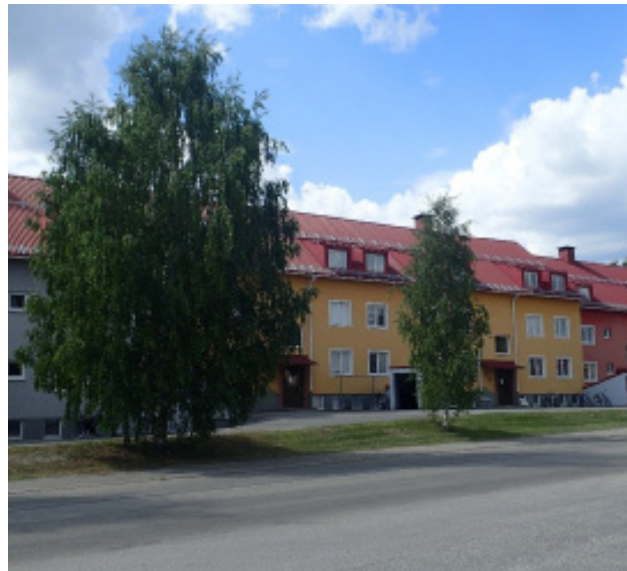
Flerbostadshusen i kvarteret Ekorren i centrala Lycksele utmärker sig genom en varierad färgsättning.
