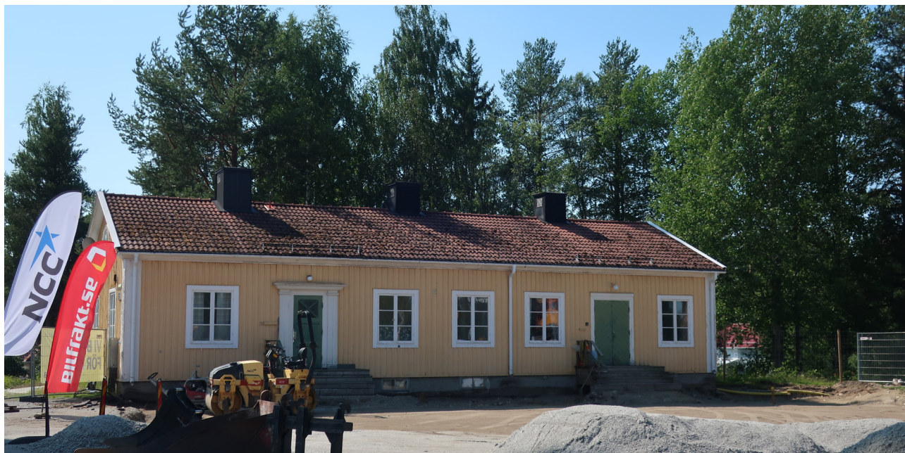
Före detta arrestlokal och polismannabostad i den östra delen av tingshustomten. Vågen 5.
