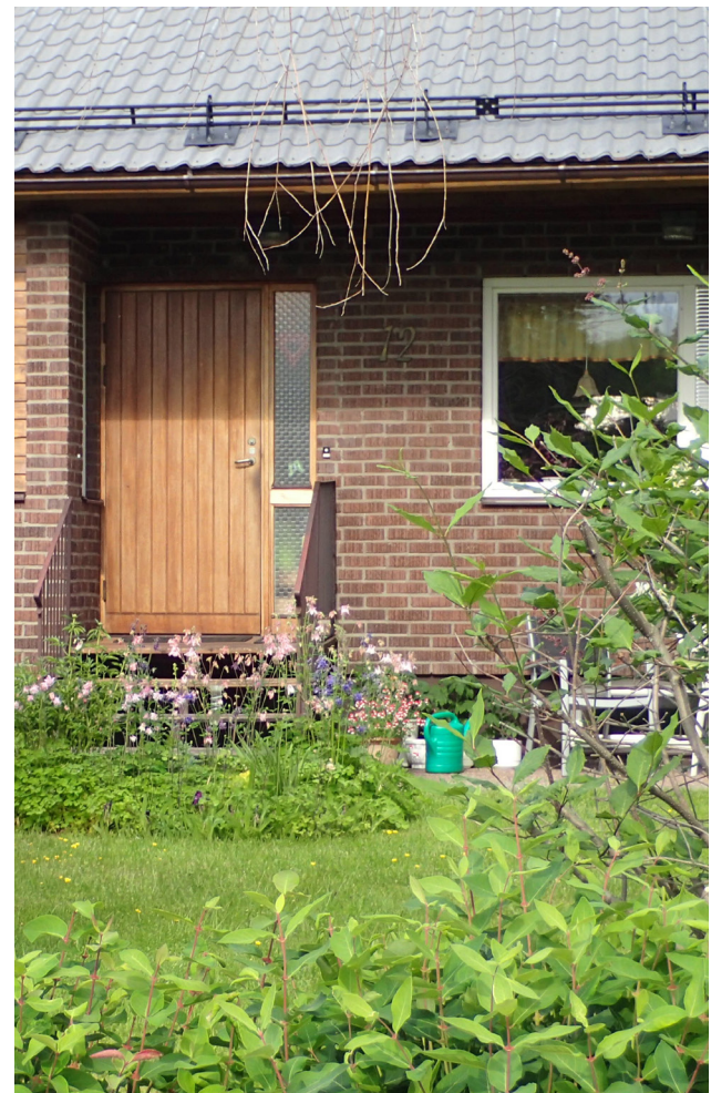
Indragen entré som skyddas av taksprånget
