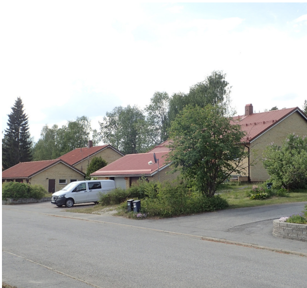
Läkarbostäder i kvarteret Ögat. Till höger entrédörr i original.
