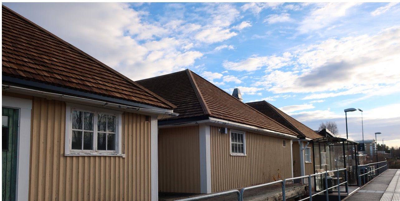
Stationshusets flyglar i söder. Spåntak, fasad och småspröjsade fönster. 1920-tal
