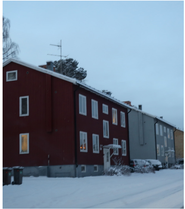
Flerbostadshus i kvarteret Lekatten
