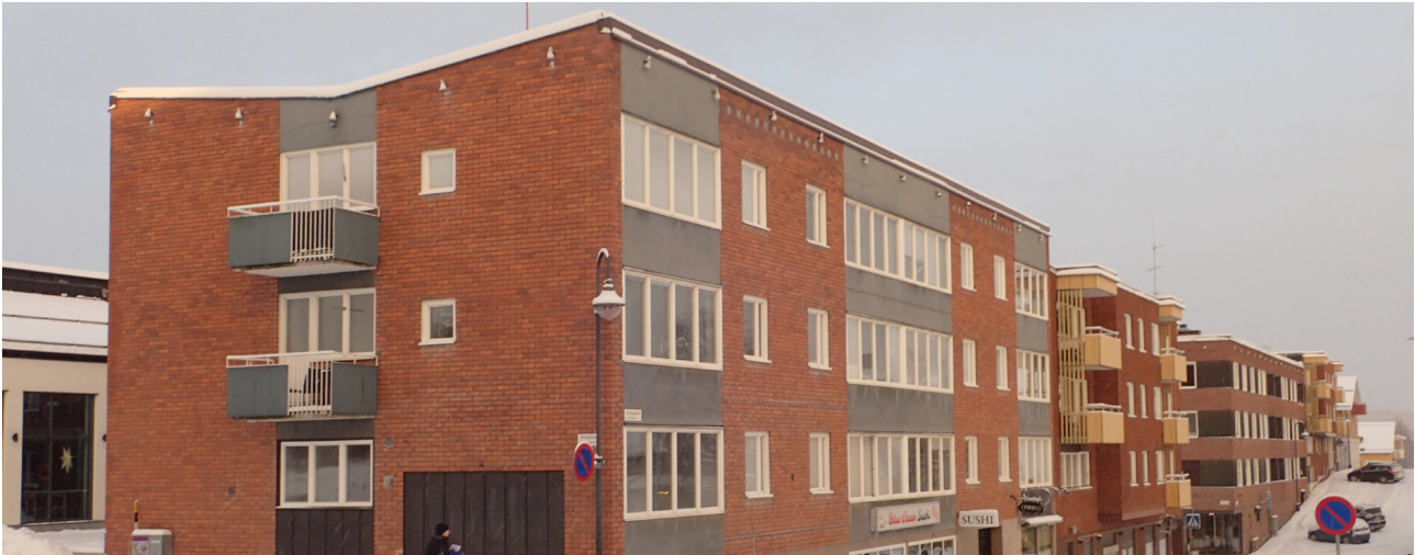
Fasad och fönsterband på fastigheten Apotekaren 1.
