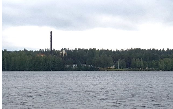
Reningsverket sett från östra sidan älven.
