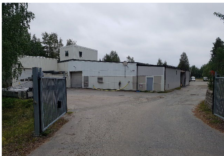
Reningsverkets huvudbyggnad och angöring.
