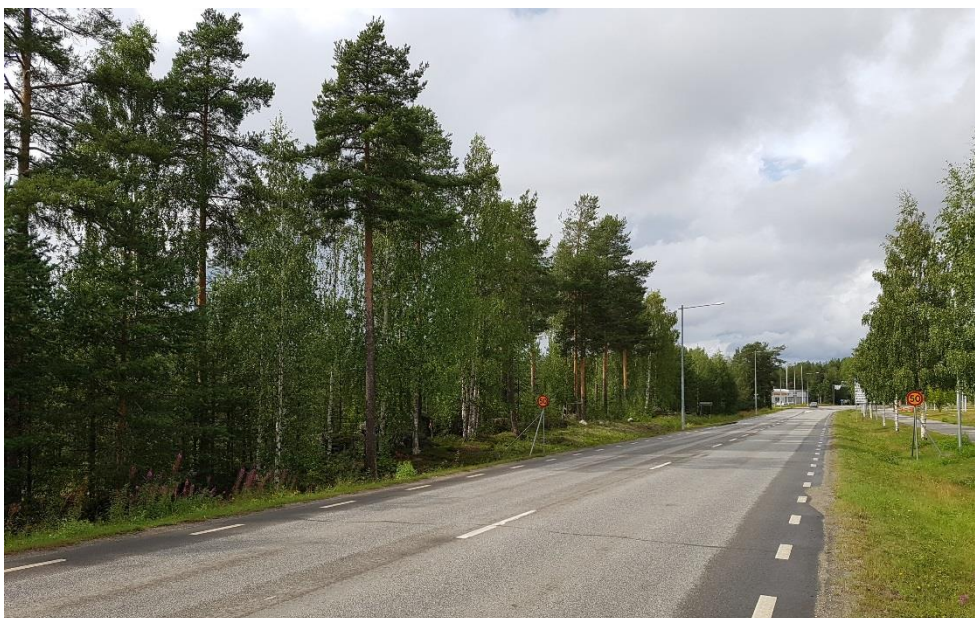
Bild 4. Befintlig skogsridå utmed E12.
