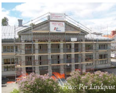
Renovering av Templens fasader under 2008
