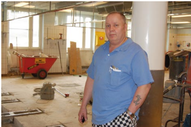
Ombyggnad av lasarettköket
