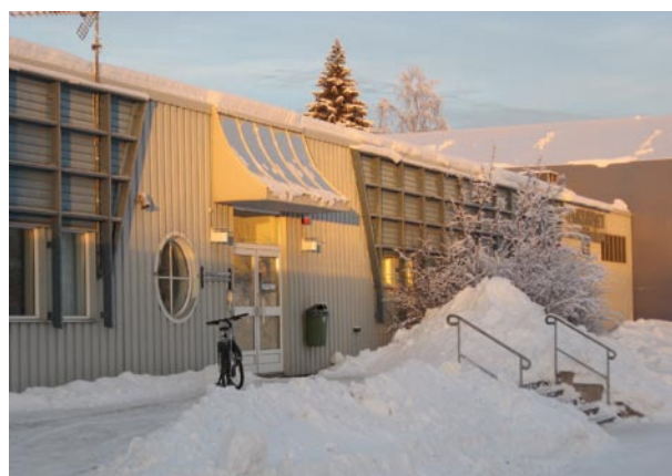
Tannbergsskolans Teknikhus i vintersol
