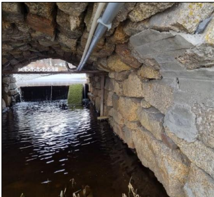
Figur 4-5. Djupskolvans utlopp till befintlig dagvattendamm under stenvalsbron.
