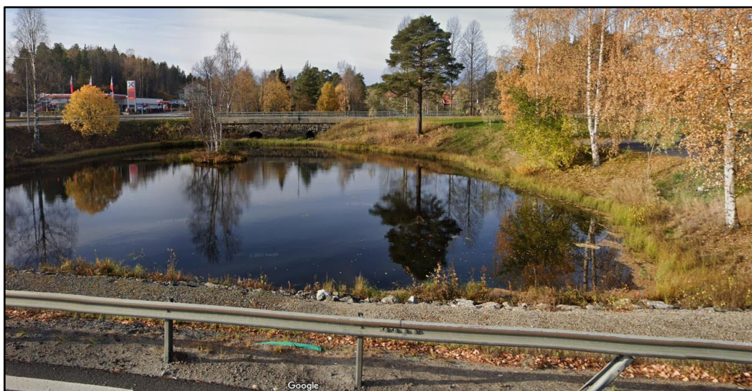
Figur 4-4. Befintlig damm med bild tagen från öster. (Bild hämtat från google maps, 2023)
