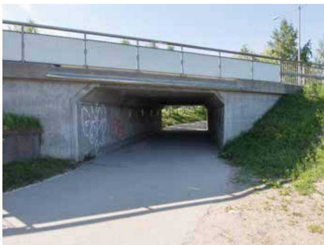
Figur 5: Befintligt port under E12 ca 250 m från bron över Umeälven.
