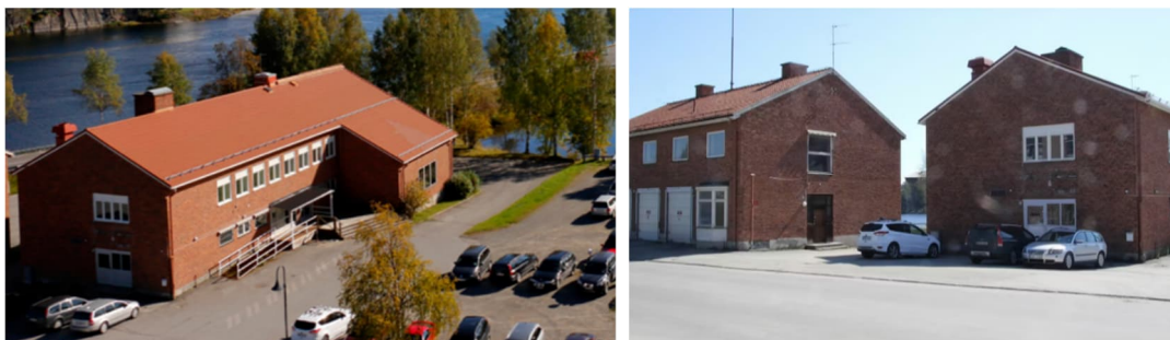
Bilder på de byggnader som tidigare fanns på kvarteret Tjärhovet.
